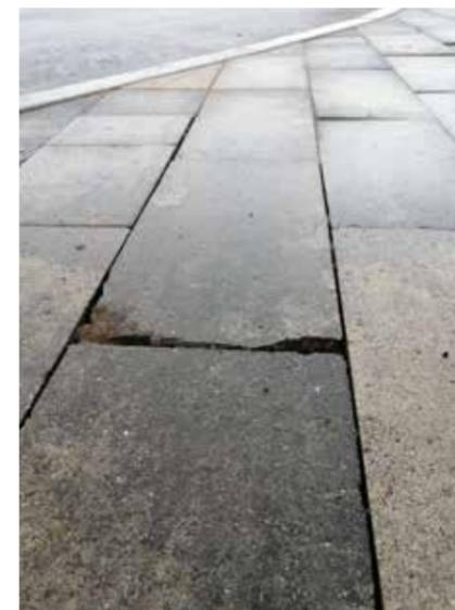
ствии. На них более равномерно распределяется нагрузка. У бесфасочной плитки угол один – 90 градусов, и, значит, риск повреждения граней намного выше. Покрытие в результате сдается в эксплуатацию либо уже с поврежденными гранями, либо с надколотыми. Дефекты проявляются, как правило, с началом интенсивной эксплуатации. При механизированной очистке тротуарного покрытия зимой происходит скалывание выступающих граней и углов плит скребком отвала дорожной спецтехники.
